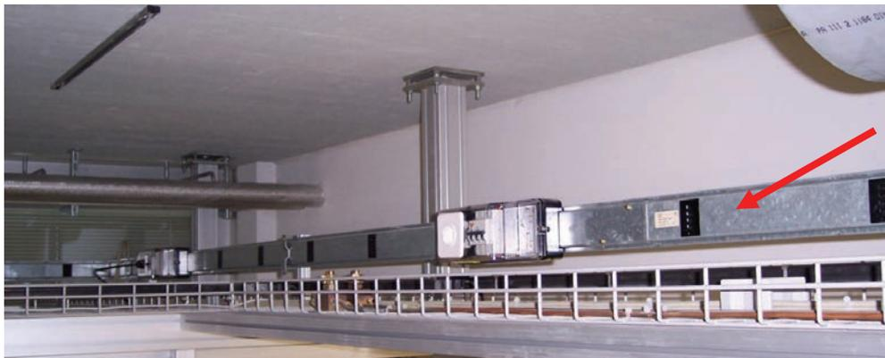
**Kurzbeschreibung:** Auf dem Deckenraster befindet sich eine Stromschiene mit Abgangseinheiten, die Leitungsschutzschalter (Sicherungen) und Steckdosen beinhalten. Daran werden die Steckdosen der Mediensäulen, die Steckdosenboxen für die Labor- und Bürogeräte angeschlossen.
