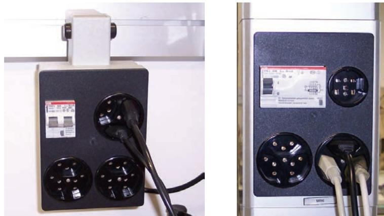
Risiko Materialfehler: Aufgrund Materialfehler brechen in diesen Strommodulen die Steckerbuchsen, sowohl die unteren, wie auch die obere.
